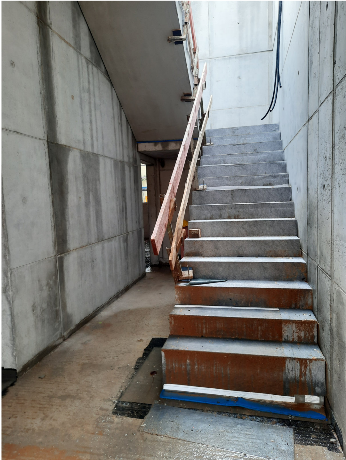
Baustelle Wirtschaftshof – Barbara Jantschke
