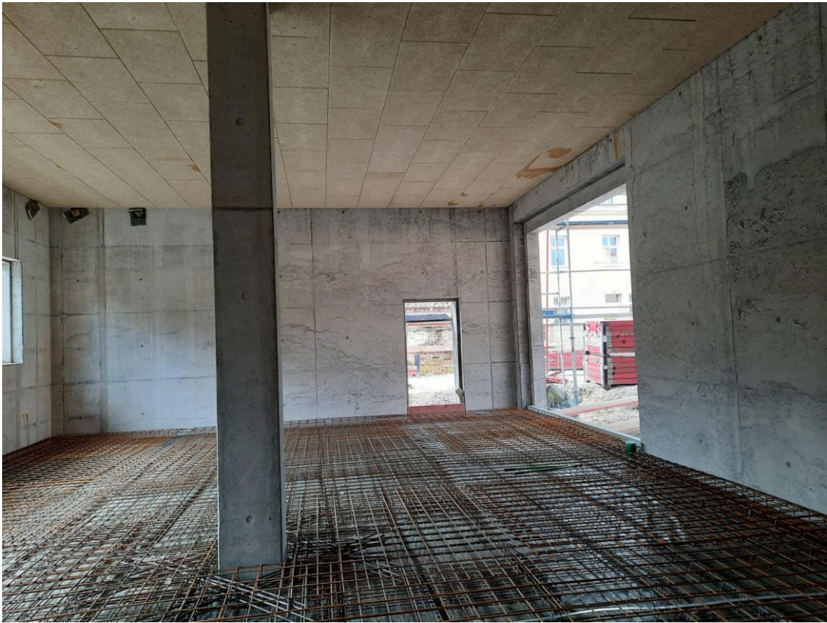
Baustelle Wirtschaftshof – Barbara Jantschke
